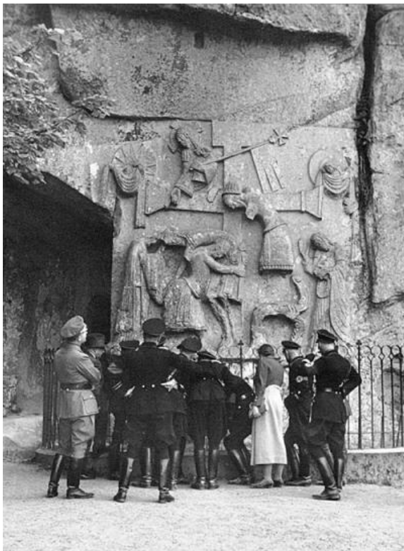
SS-Gedenkfeier an den Extersteinen, beachte die umgeknickte Irminsul
